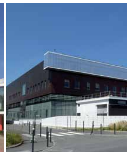
Centralny Szpital Uniwersytecki Pontchaillou, Rennes, Francja
